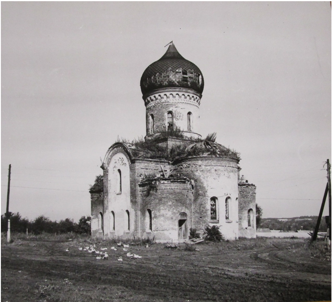
15. Вид южного и восточного фасадов.
