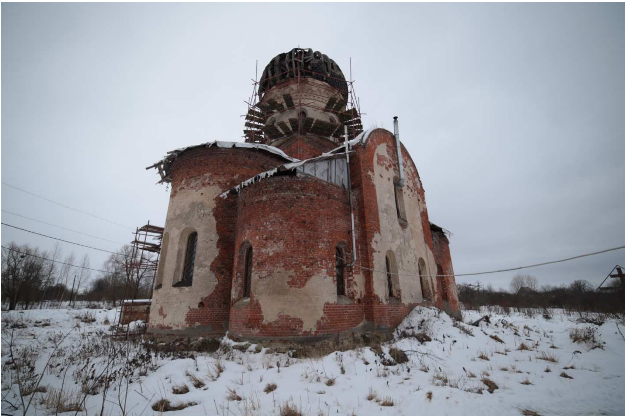
4. Общий вид объекта. Направление съемки СВ- ЮЗ.
