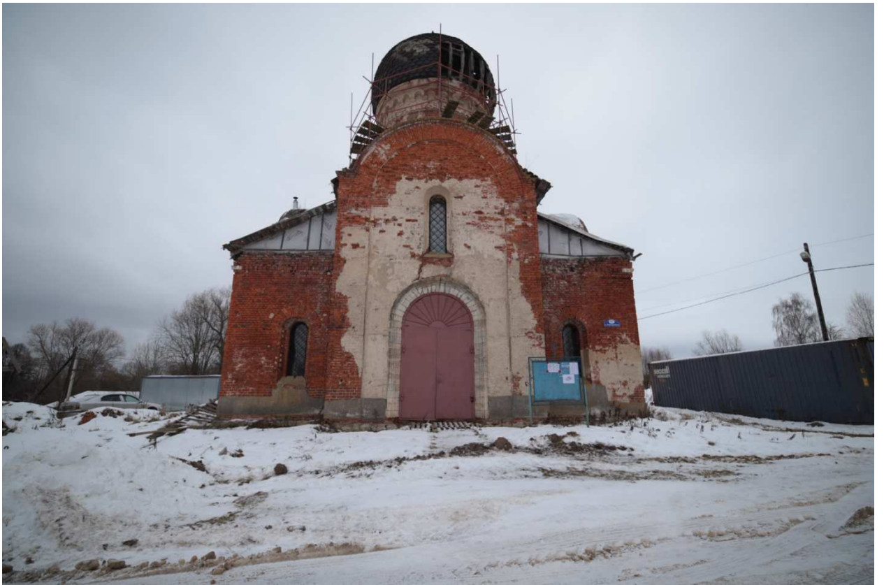
1. Общий вид западного фасада.
