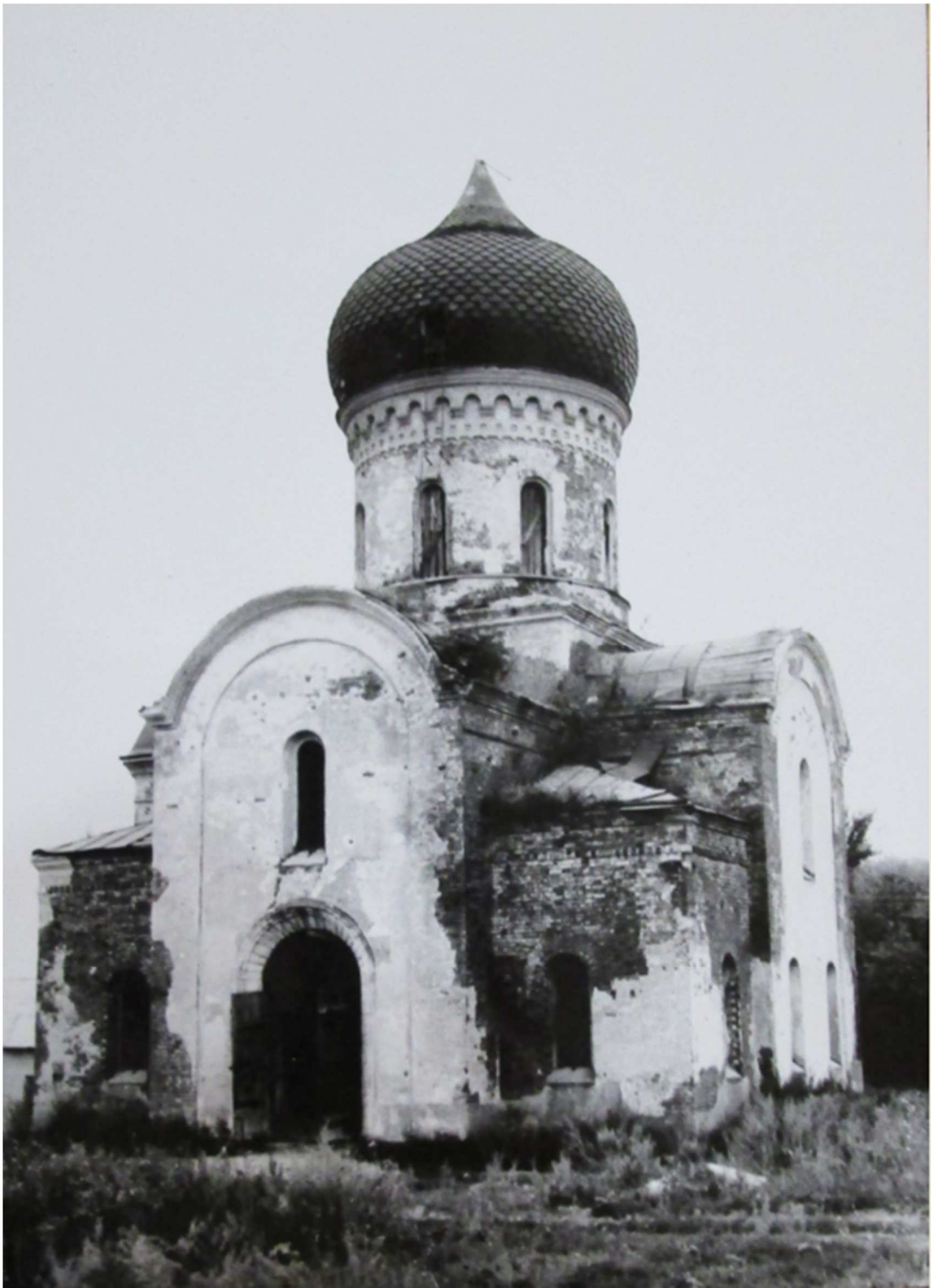
16. Вид западного фасада.
